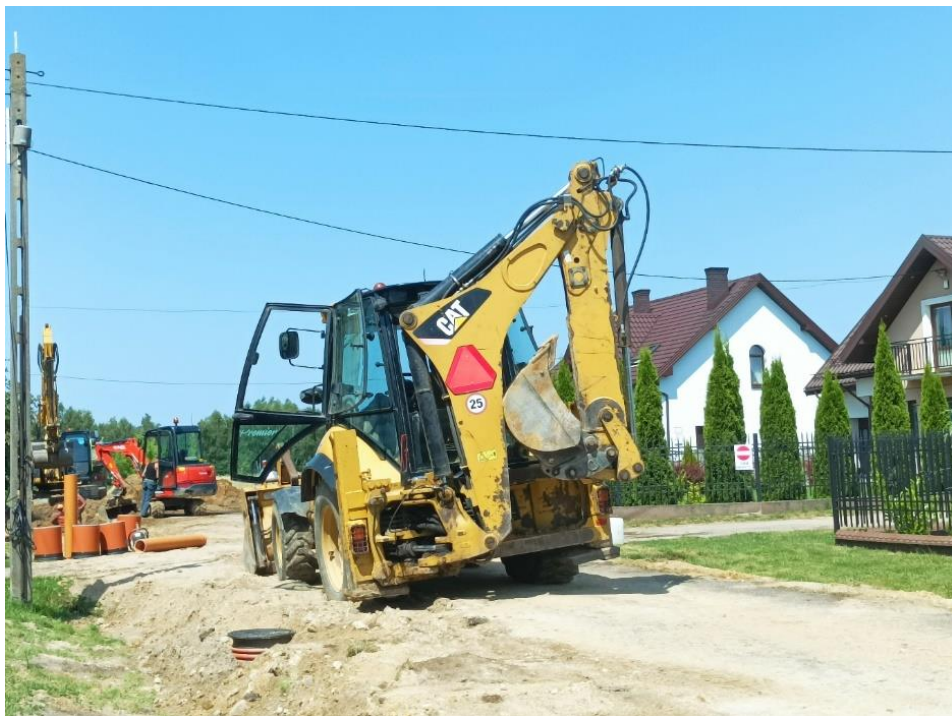
Budowa sieci kanalizacyjnej w miejscowościach Aleksandrów i Moczydła
