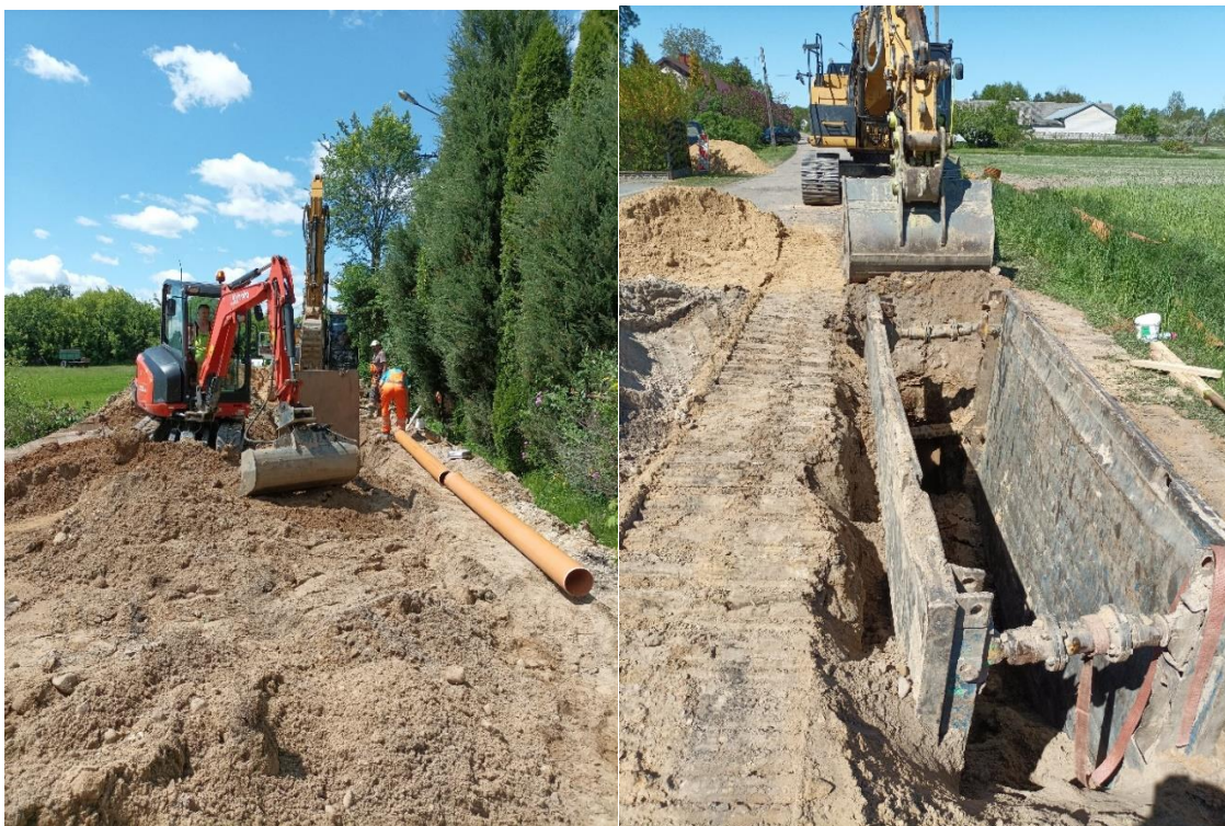
Budowa sieci kanalizacyjnej w miejscowościach Aleksandrów i Moczydła
