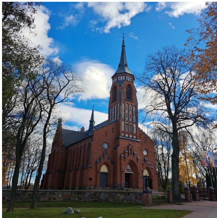
Fot. 1 Widok ogólny kościoła – elewacja frontowa(zachodnia)
