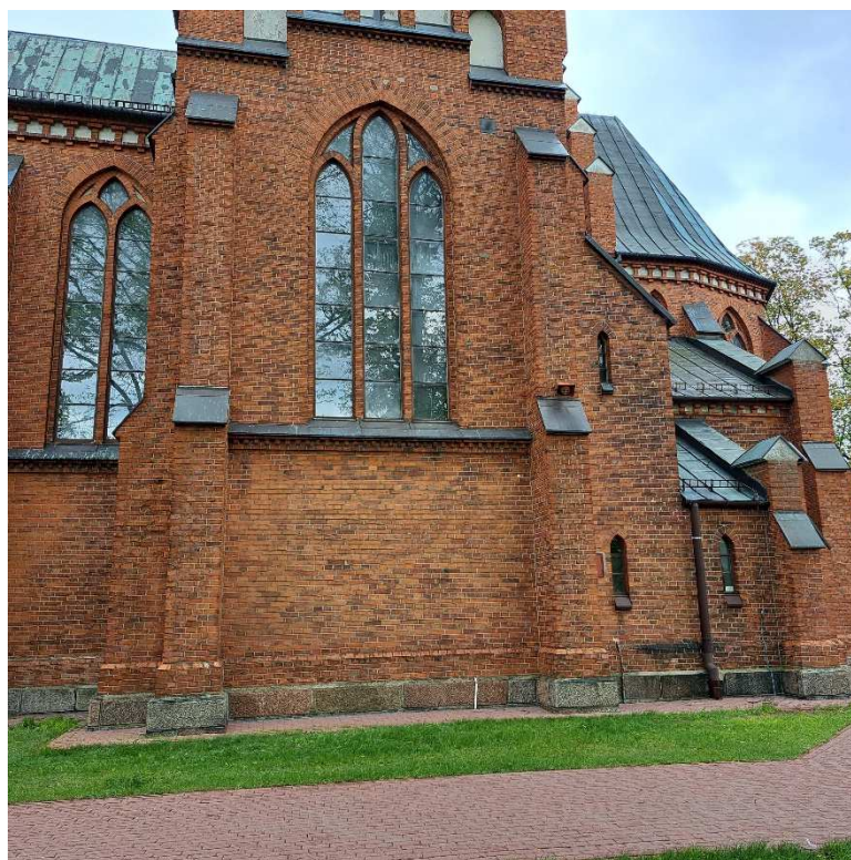
Fot. 2 Widok na cz. elewacji południowej – przewidzianej do realizacji
