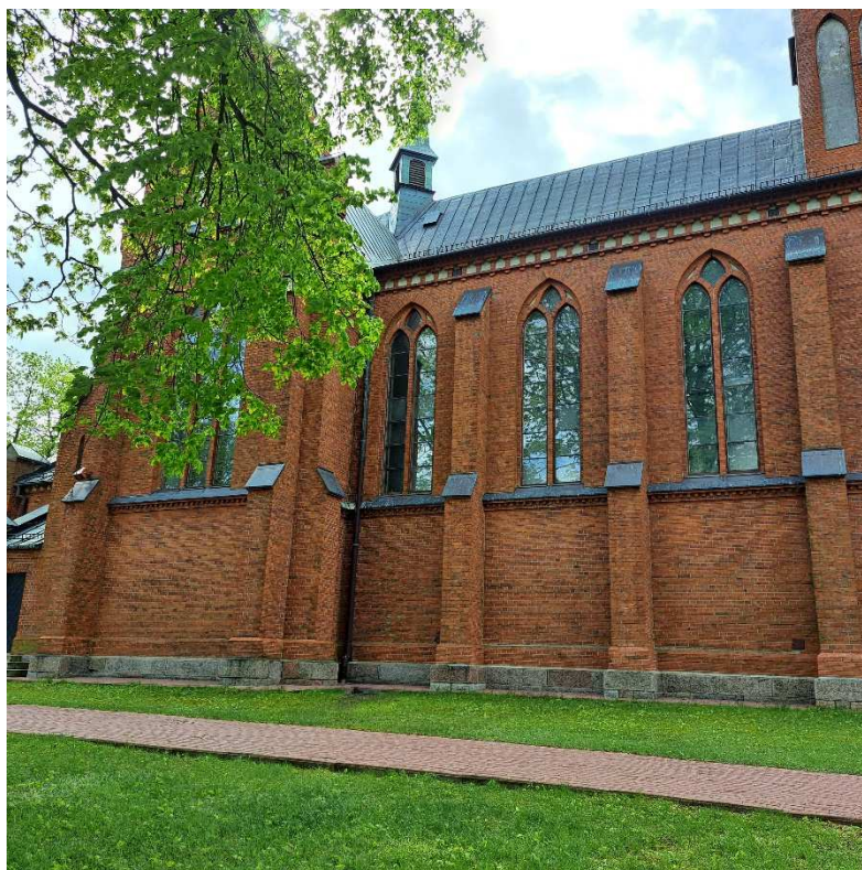
Fot. 4 Widok na elewację północną – przewidzianą do realizacji (2)
