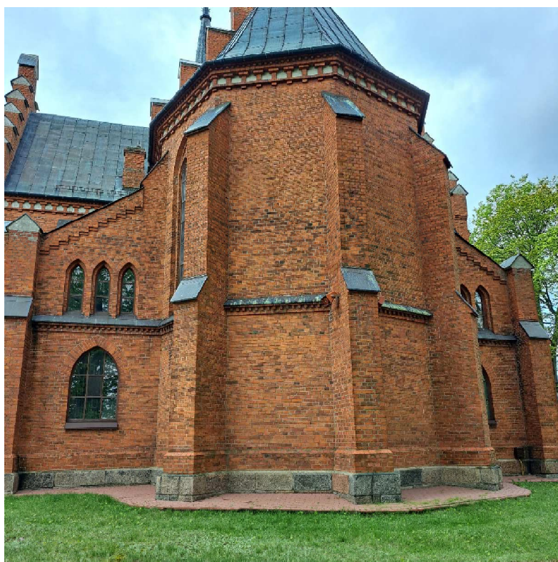
Fot. 3 Widok na elewację wschodnią – przewidzianą do realizacji
