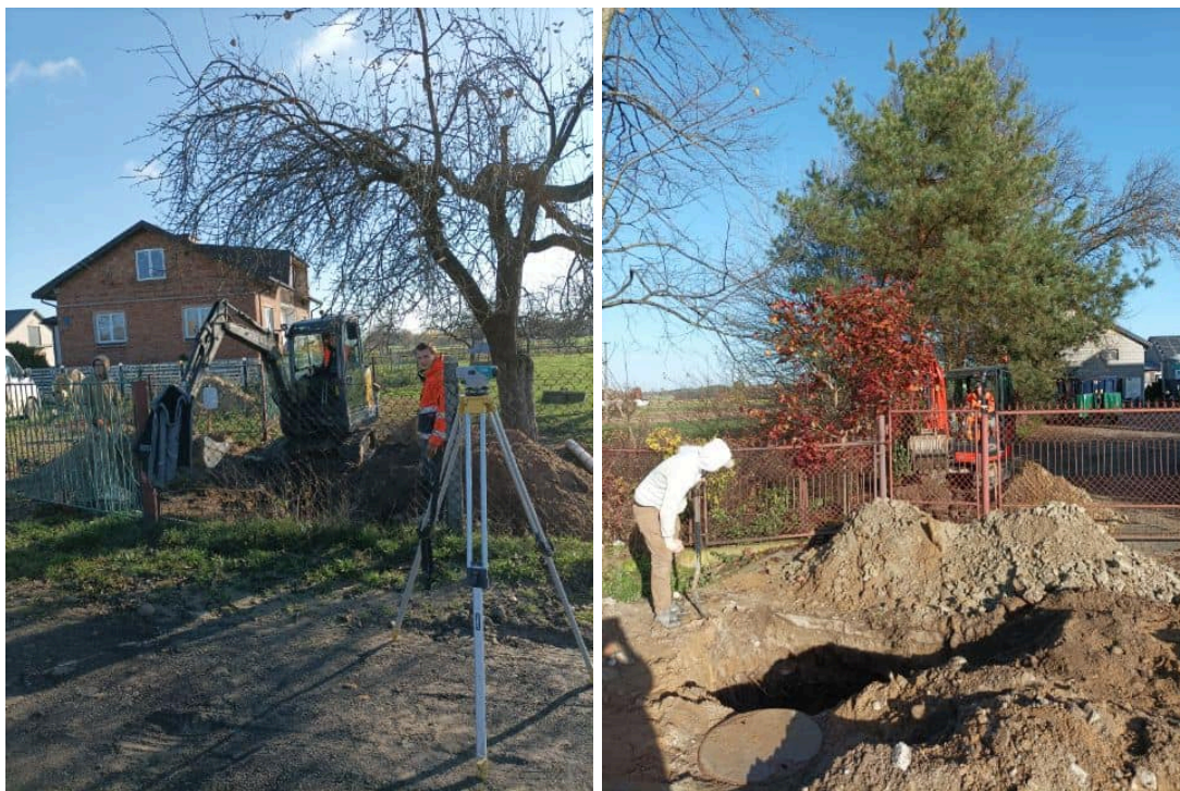
Budowa przyłączy kanalizacyjnych w miejscowościach Moczydła i Aleksandrów
