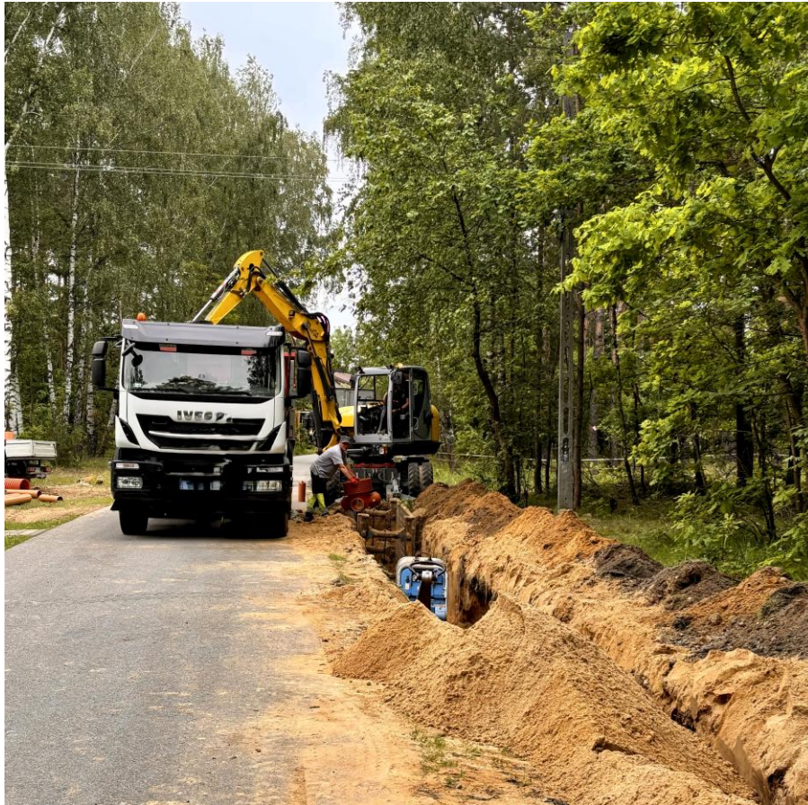
Budowa sieci kanalizacyjnej w miejscowościach Jakubów (ul. Dobra i ul. Wspólna), Izabelin, Szczytnik
