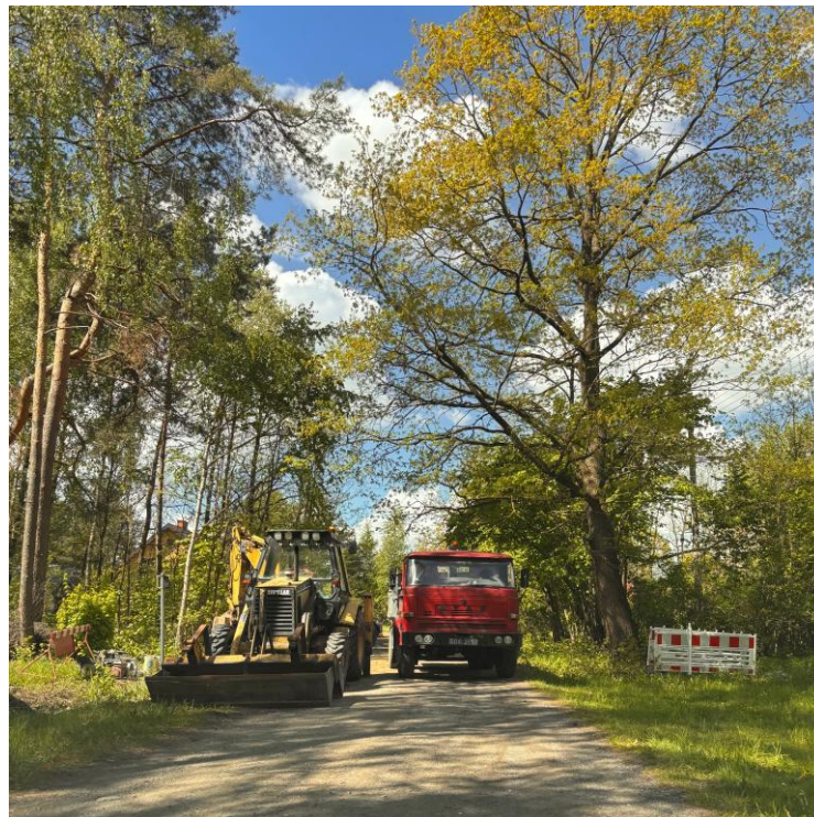
Budowa sieci kanalizacyjnej w miejscowości Rządza
